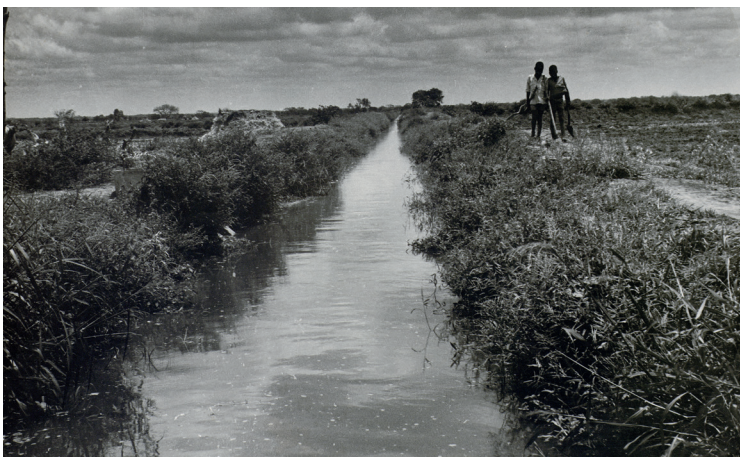
Figura 2 - O canal principal no Maguco, construído pela população que pagava a bomba da água e o gásóleo
