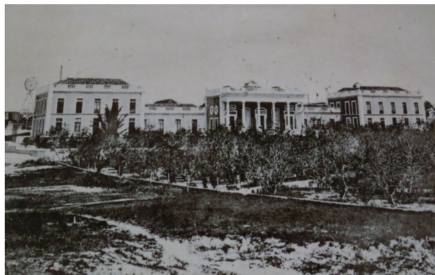
Figura 12: Hospital de Moçambique em 1906
