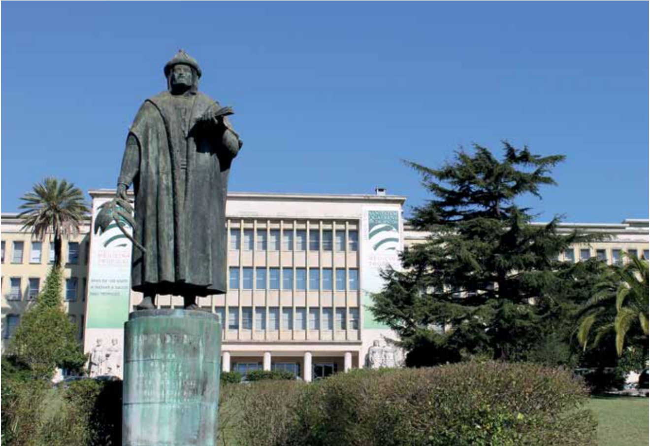
Edifício atual do Instituto de Higiene e Medicina Tropical (IHMT), um projeto do arq. Lucínio da Cruz. Com a "primeira pedra" lançada em 1952, no cinquentenário da Escola de Medicina Tropical, o edifício foi inaugurado em 1958, pelo então diretor do Instituto de Medicina Tropical, Prof. João Fraga de Azevedo. À entrada, junto à Rua da Junqueira, em Lisboa, a estátua de Garcia de Orta, do escultor Martins Correia, numa homenagem ao médico e cientista português do século XVI.
